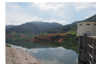
The Mengkuang Dam
